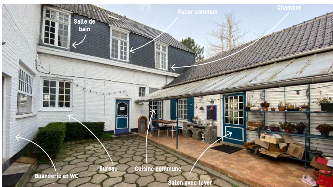
Au rez-de-chaussée, les espaces communs permettent des échanges interculturels © LAMOTE Lucas - 01/04/2021
