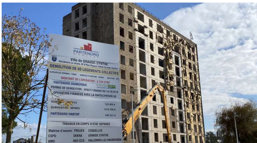
En 2020, les opérations de démolitions continuent, financées en partie par l'Etat dans le cadre du NPNRU © LAMOTE Lucas - 16/10/2020
