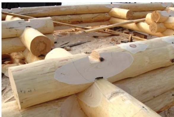
Figure 13 : Assemblage réalisé manuellement
