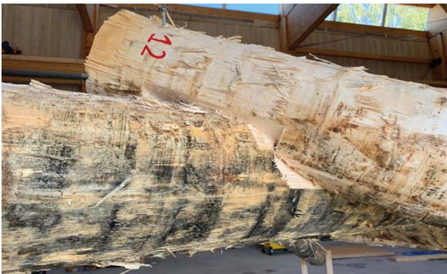
Figure 88 : Emboîtement de deux troncs lors du montage
