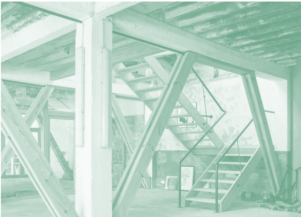
fig. 65 : Vue intérieure (niv. 0)
