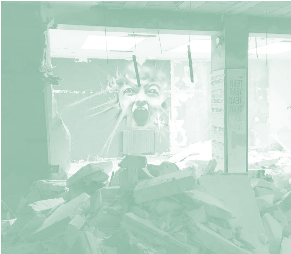
fig. 76 : Vue intérieure de l'existant
