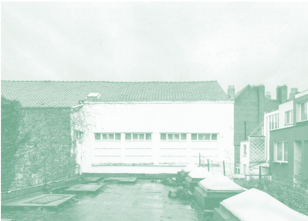
fig. 55 : Vue extérieure du site existant
