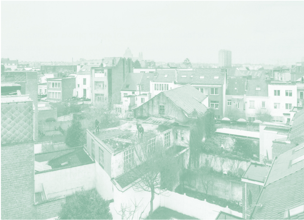
fig. 54 : Vue extérieure du site existant
