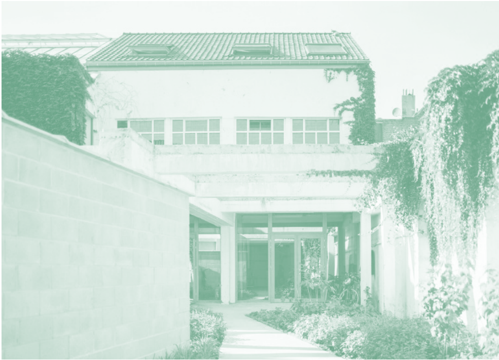
fig. 64 : Vue extérieure (niv. 0)
