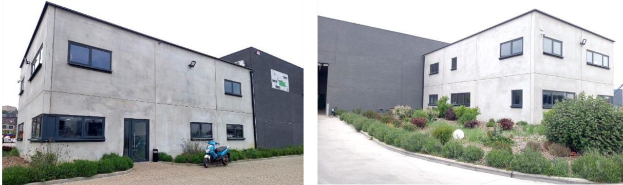
FIGURE 16 : FAÇADE AVANT DES BUREAUX RETRIVAL ET HALL INDUSTRIEL SOURCE 16 : PHOTOS PRISE PAR L'AUTEURE
