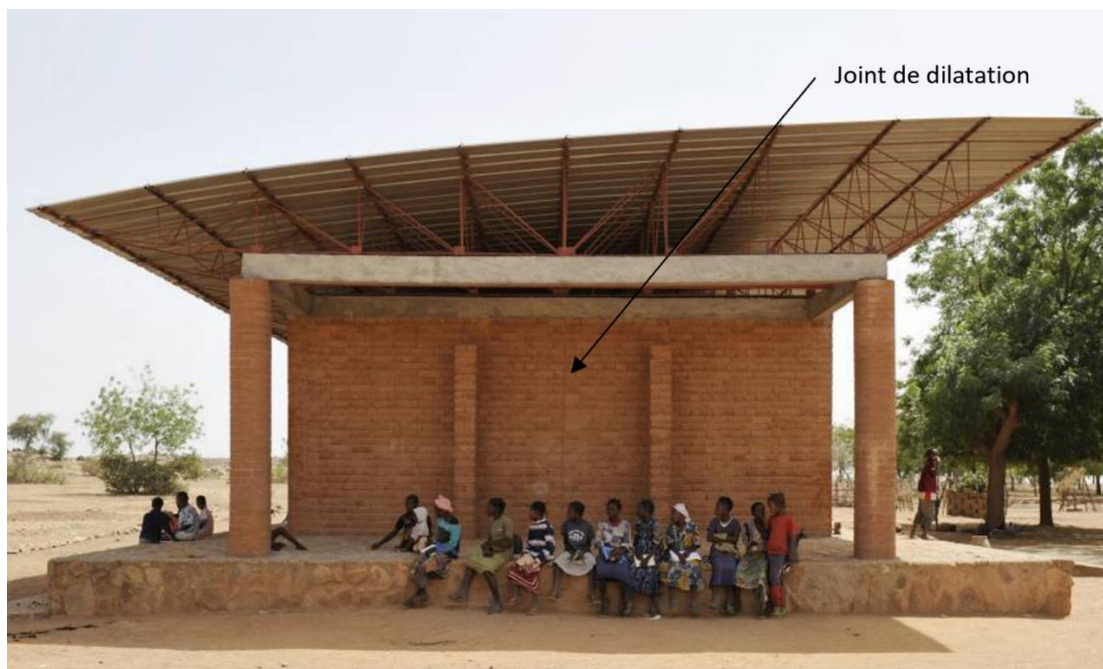
Figure 5-7 : Bâtiment en BTC réalisé par Kéré présentant un joint de dilatation (Kéré Architecture, 2024b)
