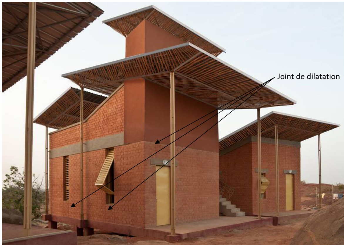
Figure 5-8 : Bâtiment réalisé par Kéré présentant des joints de dilatation (Kéré Architecture, 2024b)
