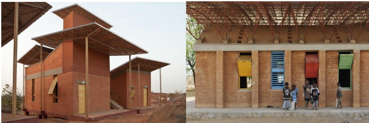
Figure 4-13 : Volet pliant en persienne utilisé par Kéré (Kéré Architecture, 2024b)
