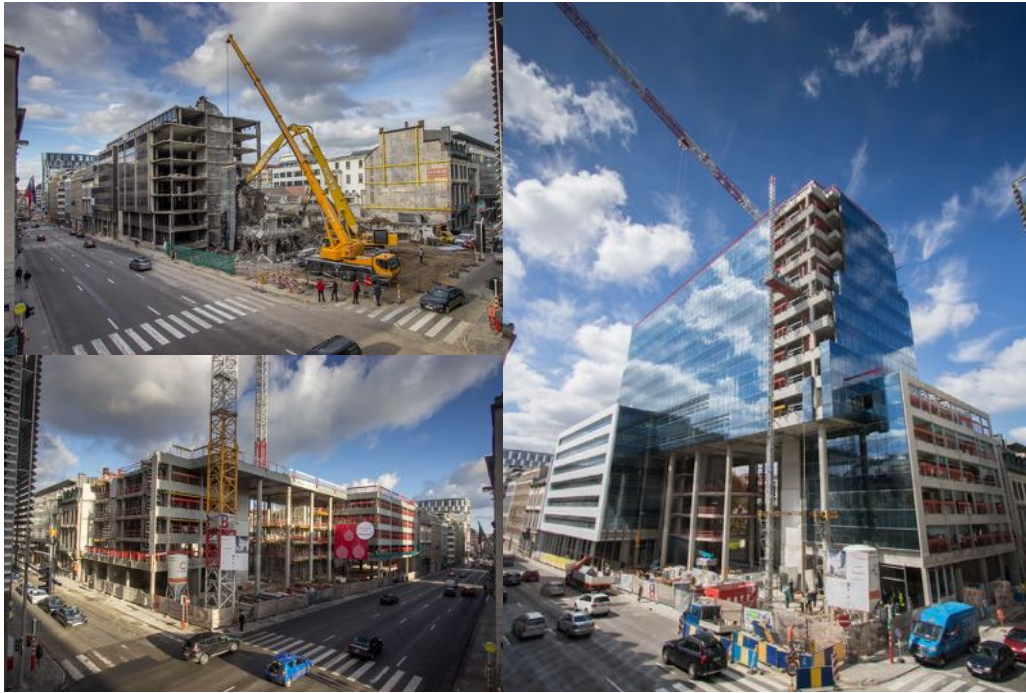
Différentes phases des travaux du Belliard 40
