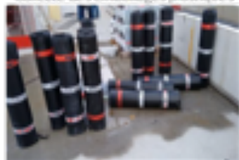
Étanchéité bitumineuse en attente de mise en œuvre dont les chutes sont récupérées par le sous-traitant
