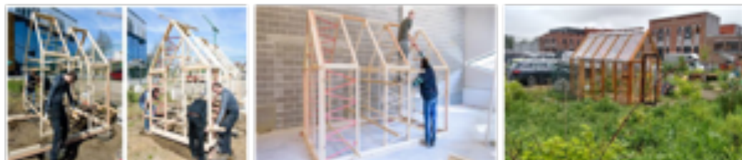
Montage d'une serre
