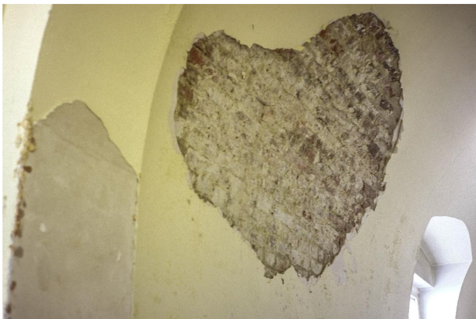
Figure 19 : Murs en mauvais état. CMC de Saint-Gilles. Corentin Hubin
